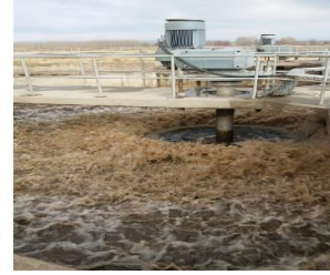
Şekil 3 Yüzey Havalandırıcısının Revizyon Sonrası Kotu
