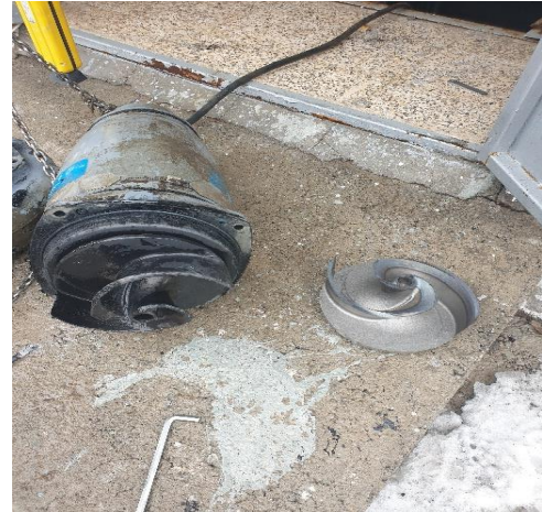
Görsel 5 Terfi pompasının çark değişimi
